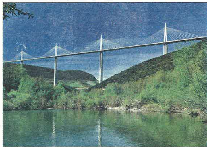
LE VIADUC DE MILLAU a fait l'objet d'un partenariat public-privé. (PHOTO: CEYLANSESTER AND PARTHIBOJANNA)
